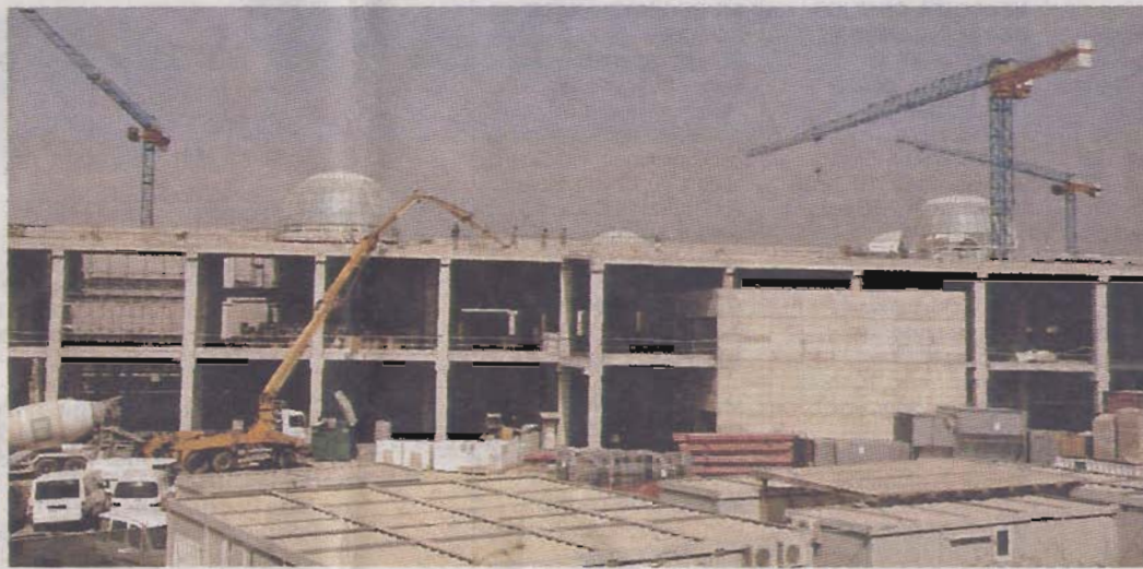
Il cantiere del centro commerciale in costruzione all'Eur
